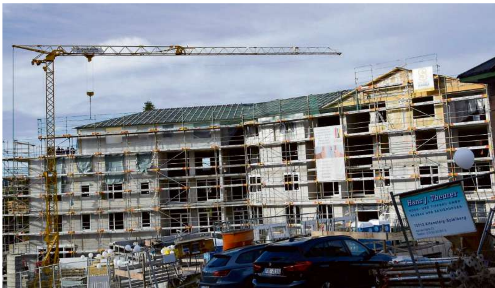
Der im Rohbau fertige 1. Bauabschnitt des „Rappenparks“ an der Straßburger Straße in Freudenstadt.
