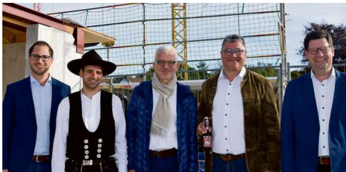
Richtfest-Ausrichter und Gratulanten im oberen Stock (von links): Michael Schneider, Zimmermann Daniel Schaible, Architekt Matthias Jarcke, Uwe Schneider und OB Julian Osswald.
