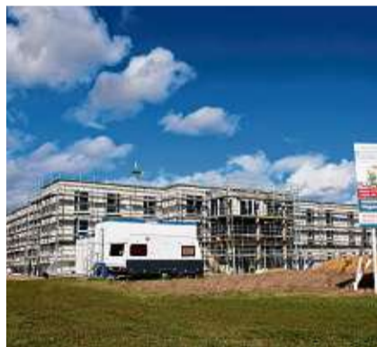
Im Tengener Gewinn Kalkgrube steht der Robau eines Pflegeheims.
