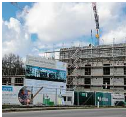
In Engen wird an der Landesstraße 191 ein neues Pflegeheim von einem privaten Investor und Betreiber gebaut.
